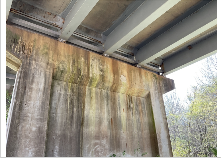
Bent 3 cap Delam
